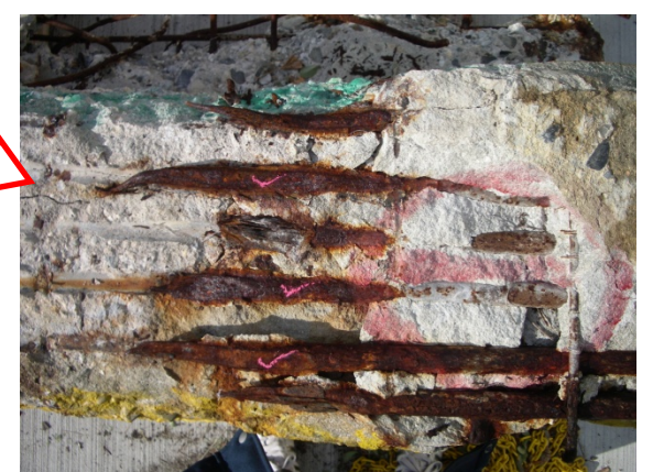
支承部の鉄筋
