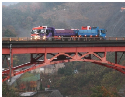
荷重車を用いた静的載荷試験
