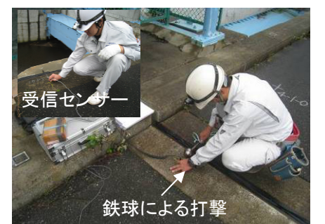
弾性波速度測定(橋軸方向) (社) iTECS技術協会
