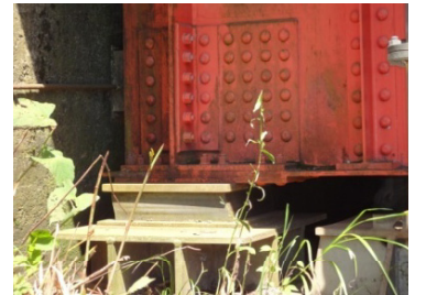
桁端部のあて板補強とゴム支承への取り替え
