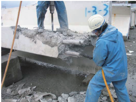
解体調査状況
