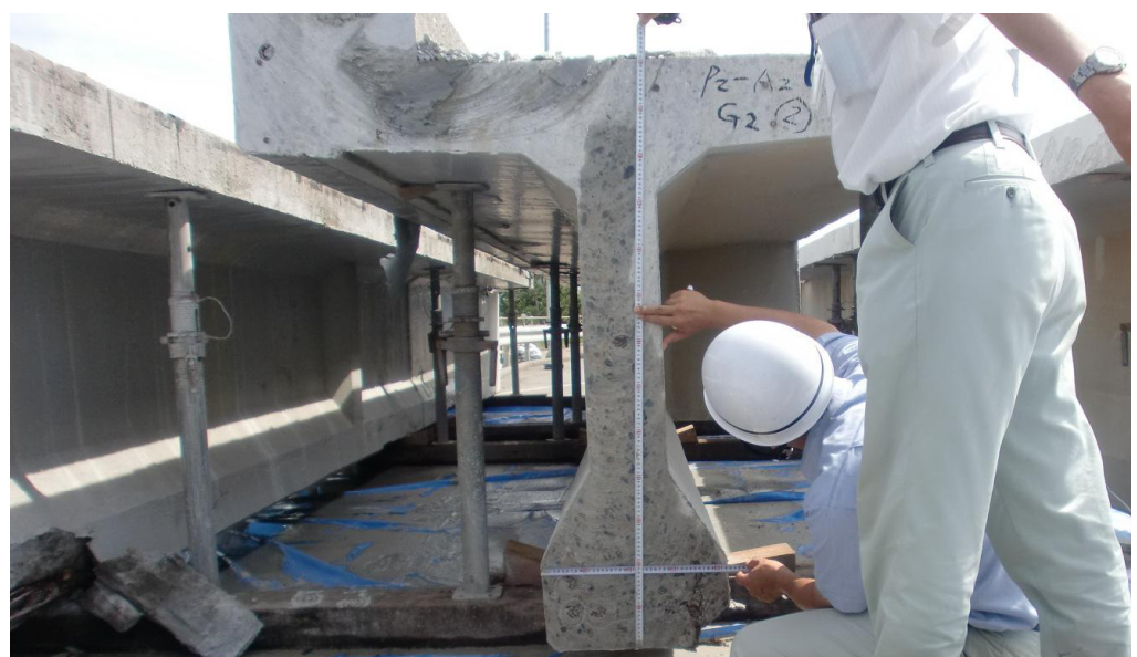
桁切断面の調査状況
