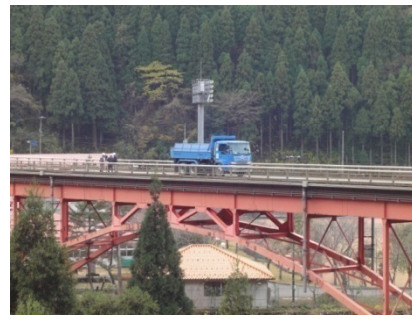
荷重車を用いた走行試験 ＜載荷試験の実施状況＞
