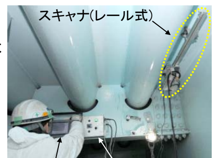
超音波探傷器 自動走査装置の操作盤 現場における探傷事例
