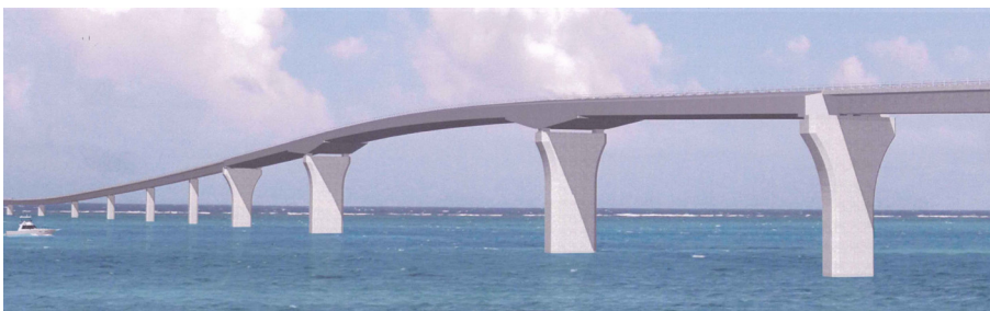
現在建設中の伊良部大橋
