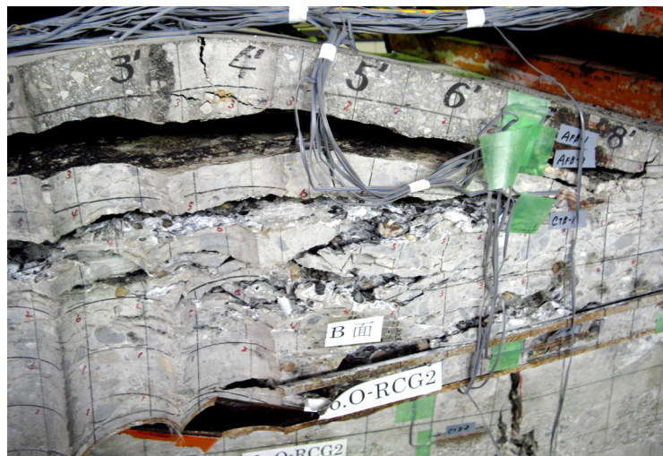
圧壊付近の上フランジ側面の状況
