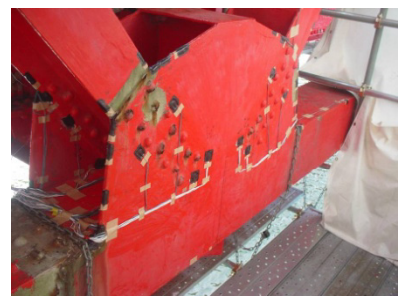
ひずみゲージ貼付状況
