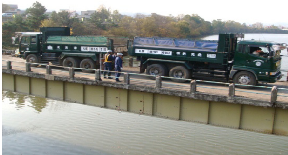
荷重車を用いた現地载荷試験
