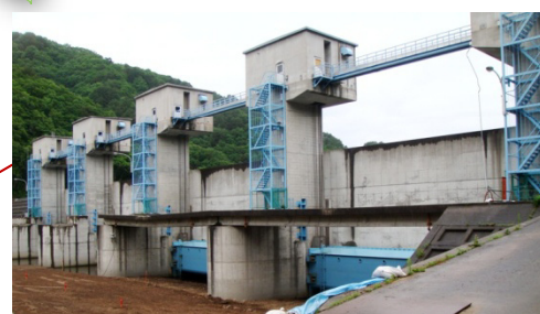
普代水門管理橋
