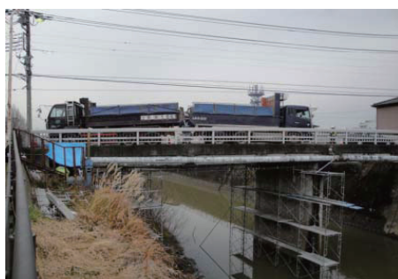
A 橋載荷試験状況
