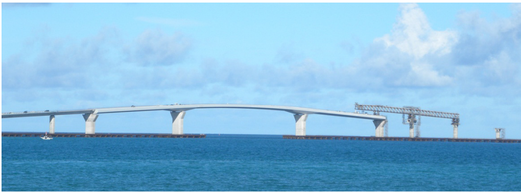
現在建設中の伊良部大橋
