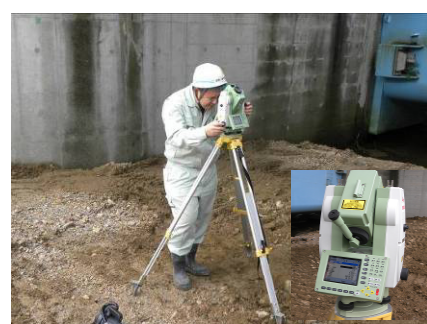
光波測量器によるひび割れ計測 (関西工事測量(株))
