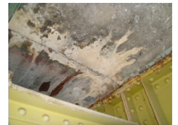
床版目地の漏水、遊離石灰
