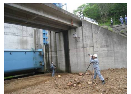
デジタルカメラによるひび割れ計測 (首都高技術(株))
