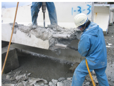
解体調査状況
