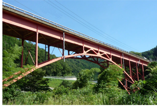
46年間供用, 疲労・腐食損傷に対し補強対策を実施
