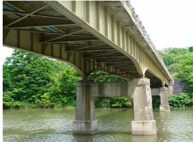
床版目地の漏水、遊離石灰
