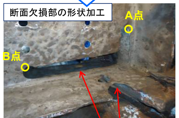
ホールソー, グラインダによる断面欠損部の加工
