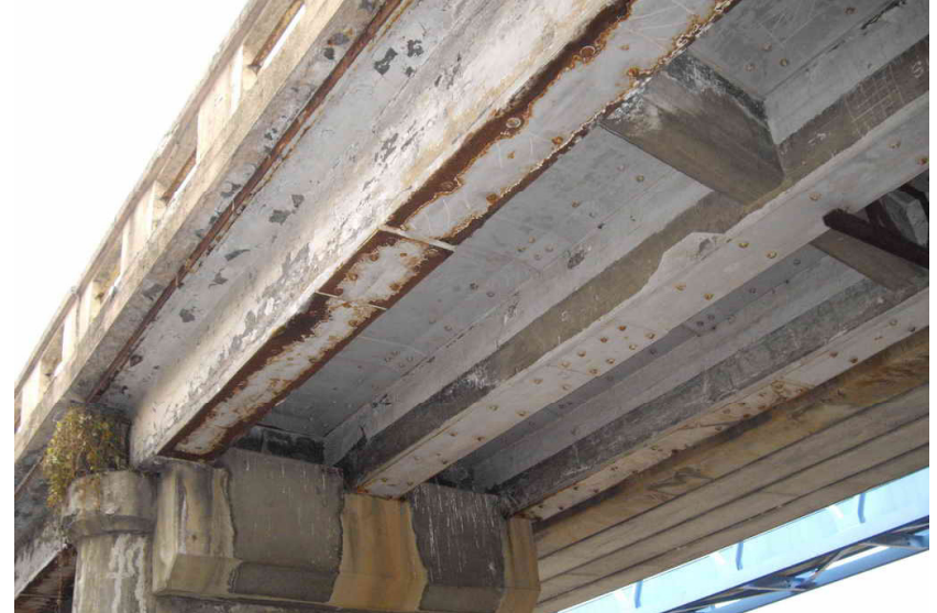
ワンサイドボルトの軸力により鋼板同士の接着強度を改善
