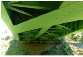
※T橋, 鋼単純合成鉄桁橋(設計荷重TL-20) 橋長(支間長);32.26m 竣工年;昭和43年(1968年)
