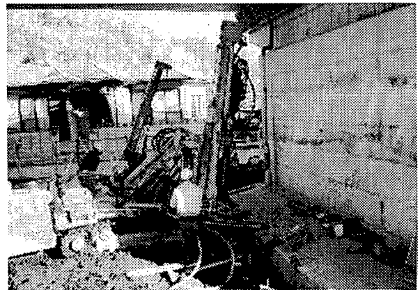
写真-4.1.4 施工状況
