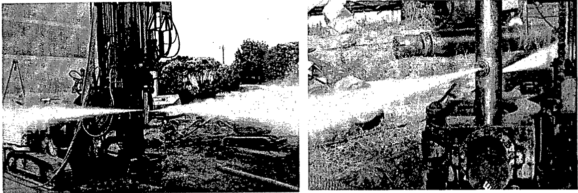
図-解 3.4.2 ツインノズルロッドによる超高压噴射
