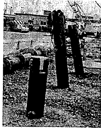
写真-4.4 斜杭施工完了状況
