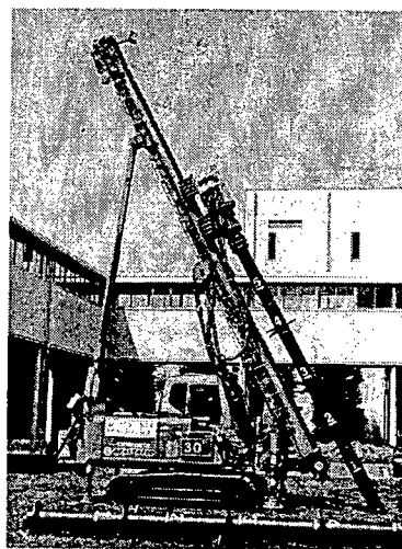
写真-4.7 斜杭施工状況
