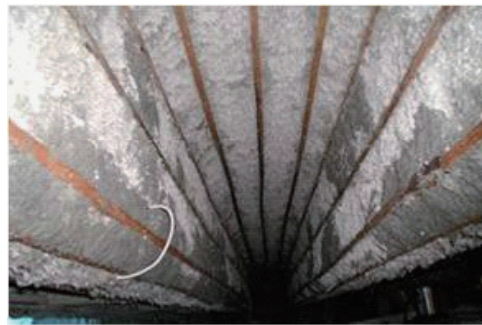
ファイバーの吹付け完了
