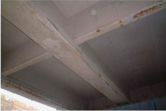
施工前の状況
