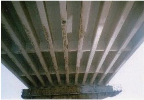
施工前の主桁下面状況
