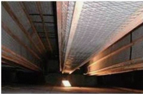
陽極の設置完了
