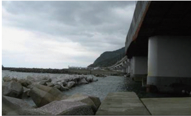
施工現場状況
