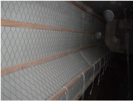
外部陽極の取付け
