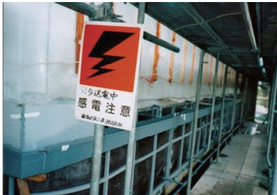
電解質溶液保持材取り付け完了
