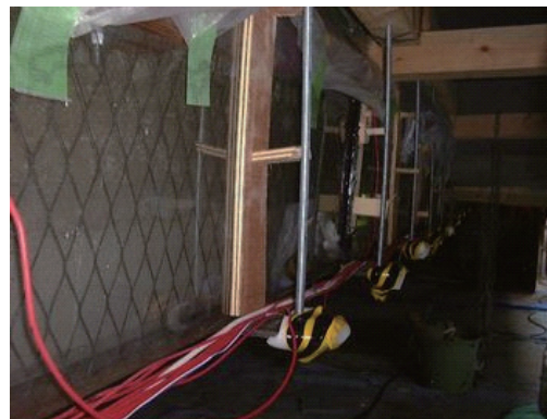
パネル（電解質溶液槽）設置状況
