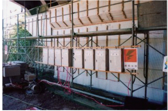
電解質溶液保持材取り付け完了
