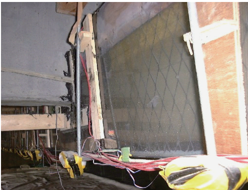
パネル（電解質溶液槽）設置状況
