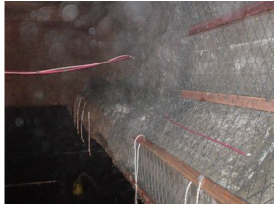
ファイバーの吹き付け途中
