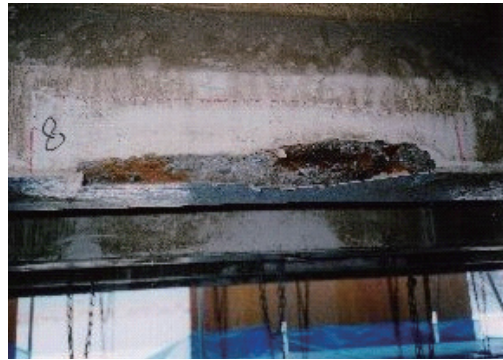
断面修復前の状況
