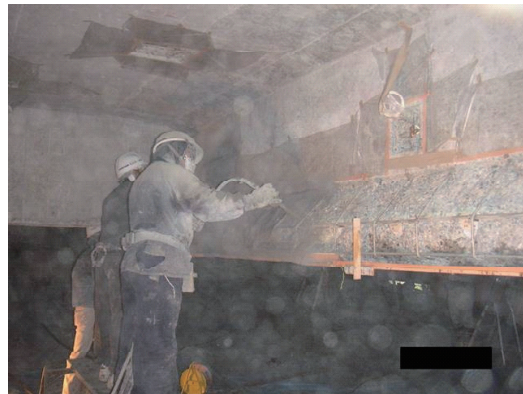
断面修復工法（湿式吹き付け工法，脱塩施工前）
