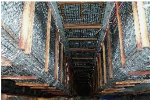
ファイバーの固定 (プラスチック製ネット)
