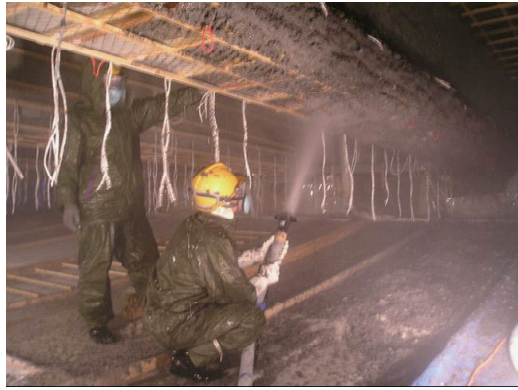
ファイバーの吹き付け状況
