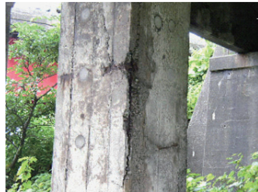
構造物の外観 (脱塩施工後 10 年, 左: 脱塩を行った部位, 右: 脱塩を行っていない部位)
