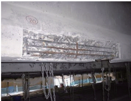
P C 鋼材の状況
