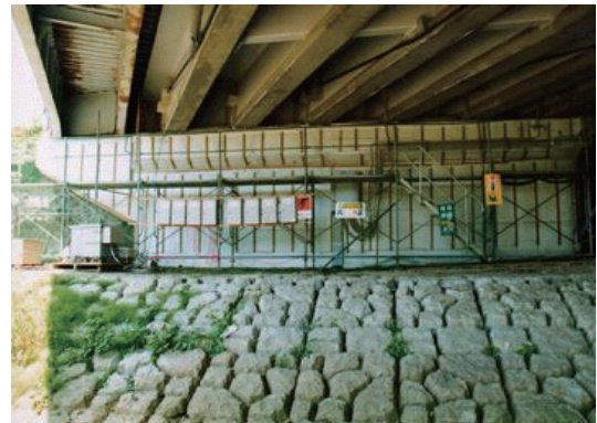
橋台の脱塩状況
