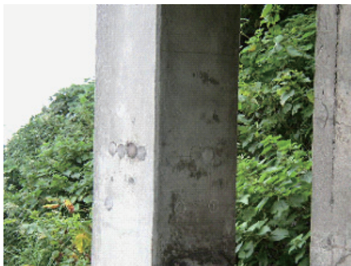
構造物の外観 (脱塩施工後 10 年, 左: 脱塩を行った部位, 右: 脱塩を行っていない部位)
