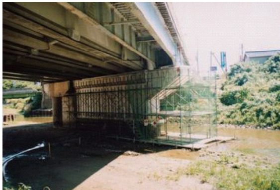
橋脚の脱塩状況
