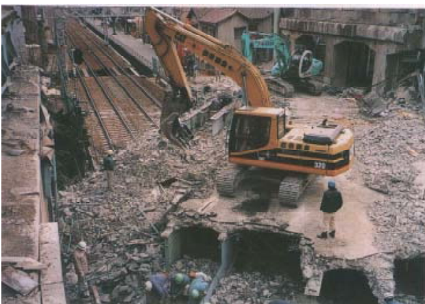
写真. 斜橋の落橋(兵庫県南部地震)
