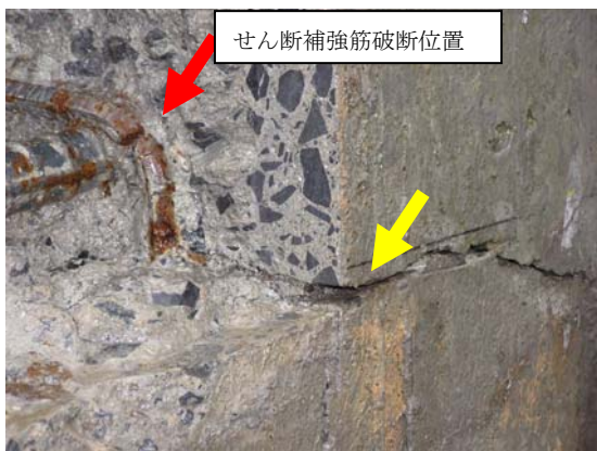
図一解 10. 3. 2 ひび割れと鉄筋破断箇所の位置関係の例
