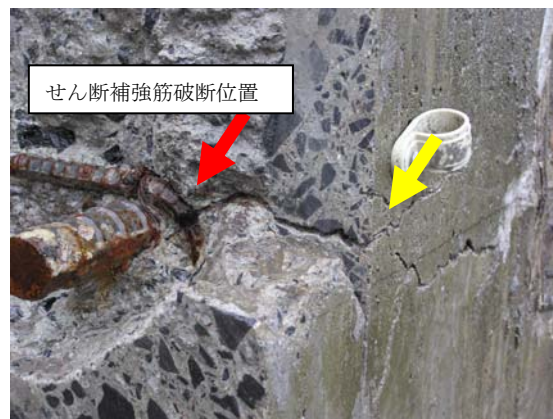
図一解 10. 3. 2 ひび割れと鉄筋破断箇所の位置関係の例
