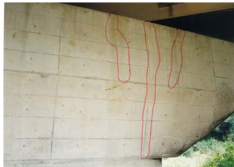
図一解 4.2.5 曲げひび割れの例 (実構造物, 赤線の枠内にひび割れ)
