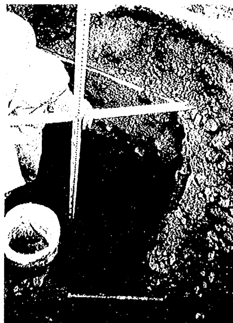
写真-6.3 試掘状況写真
