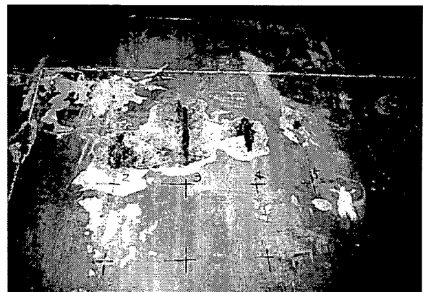
写真-1.2 地下室側壁の現況
