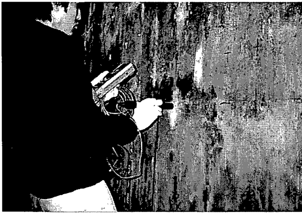
写真-1.3 Nb法（飽和塩化銀電極）測定状況
