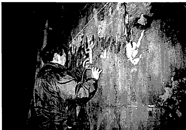
写真-1.5 Nb法（水銀酸化水銀電極）測定状況
