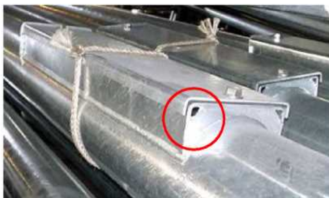
水抜き孔と止水パッキンによる滞水環境の改善事例
