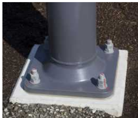
応力集中を緩和するため溶接部の形状に配慮した事例
