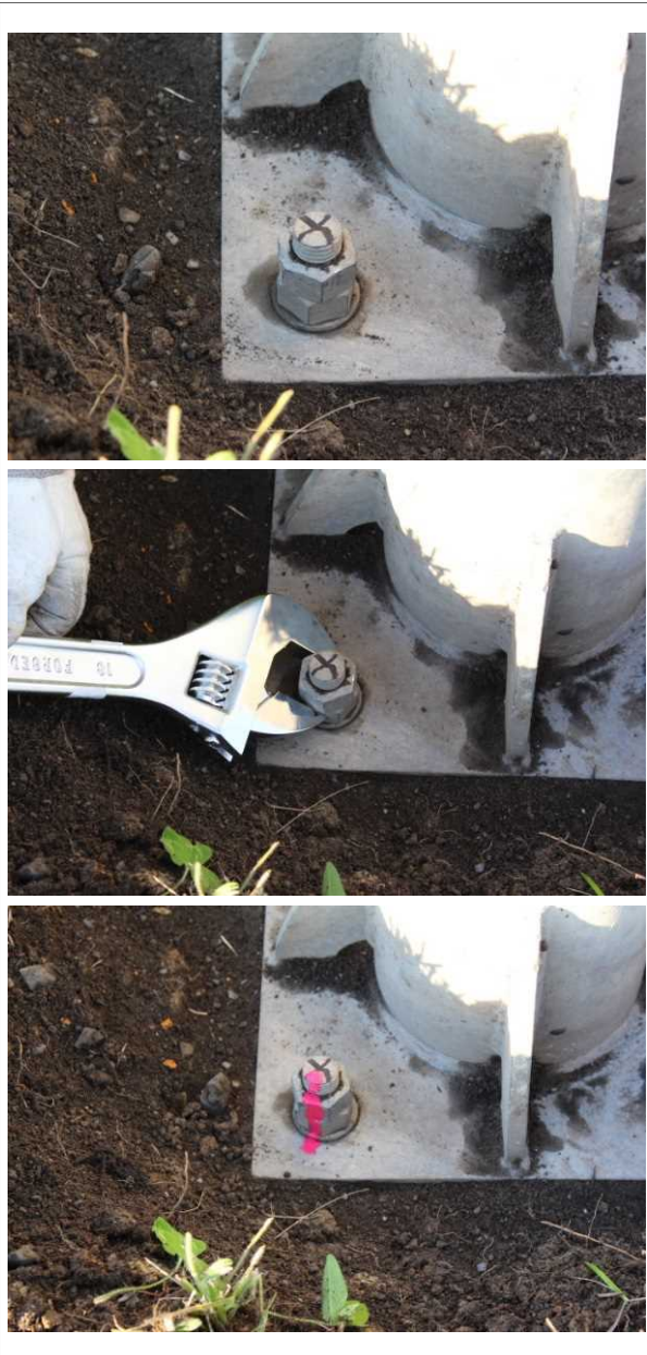
増し締め及び合いマークの施工例
