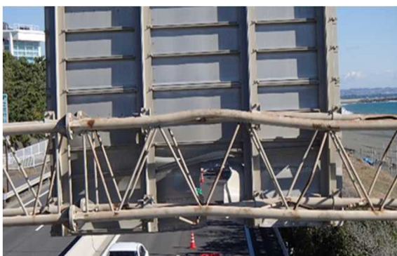
標識板や灯具取付部の損傷事例
