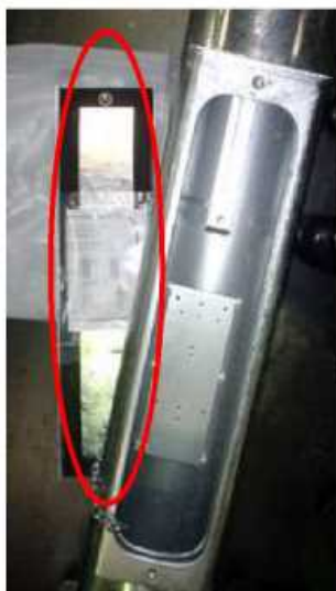
水抜き孔と止水パッキンによる滞水環境の改善事例
