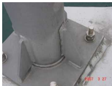
支柱基部に発生したきれつの事例
