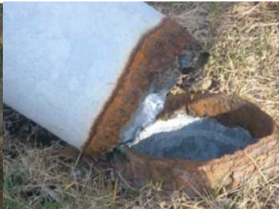
支柱基部に発生している腐食の事例
