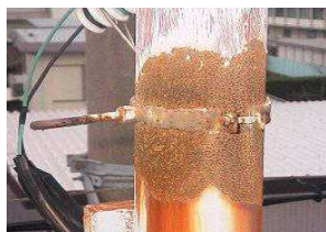
異種金属接触腐食への対応が必要な事例
