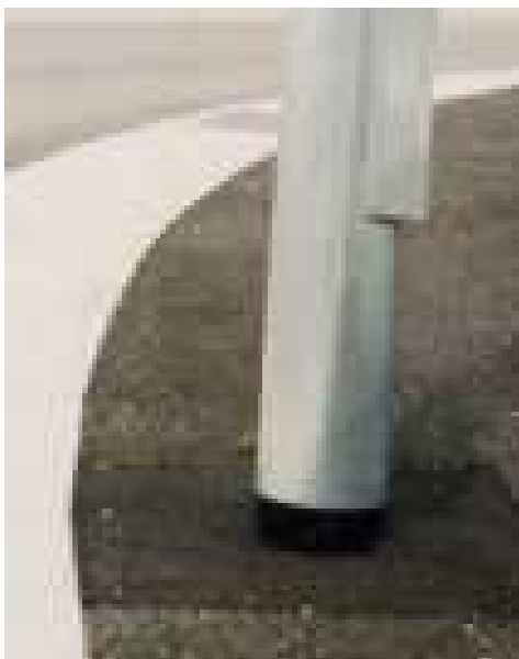
路面境界部の防食
