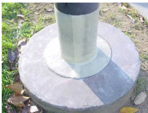
基部の補修事例
