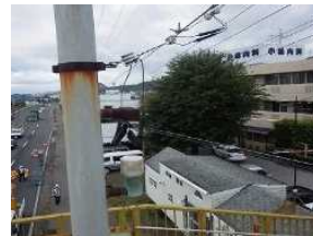
異種金属接触腐食への対応が必要な事例
