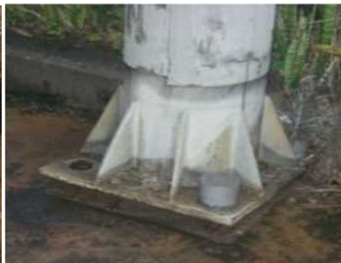
支柱基部に発生している腐食の事例
