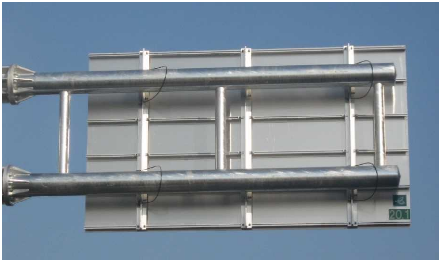
F型標識の落下防止ワイヤーの設置例
