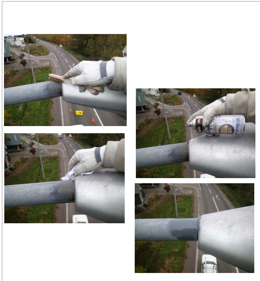
腐食の清掃と防食処理
