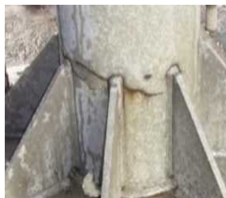
支柱基部に発生したきれつの事例
