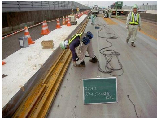
図-4.5.3 スタッド設置工
