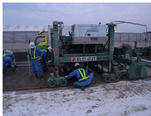
(b) フィニッシャーを用いた締固め
