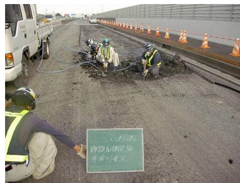
(b) 人力による舗装下部の切削
