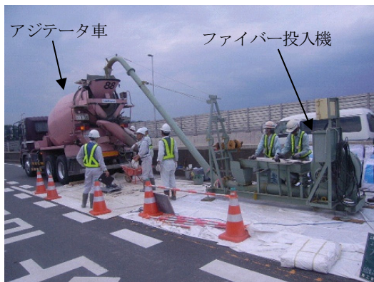
図-4.5.7 鋼繊維の投入
