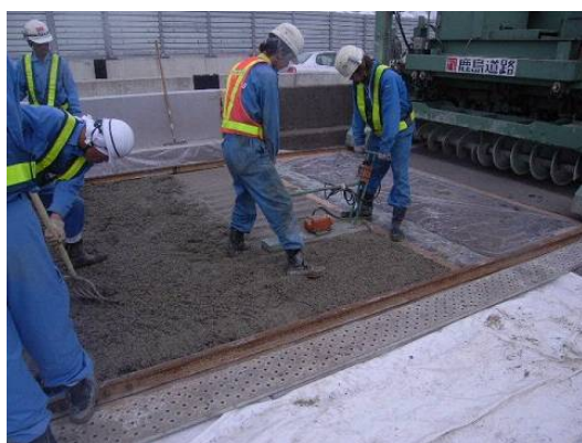
(a) 平面バイブレータを用いた締固め
