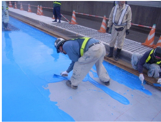
図-4.5.4 接着材塗布工
