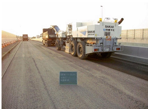
(a) 路面切削機による舗装上部の切削
