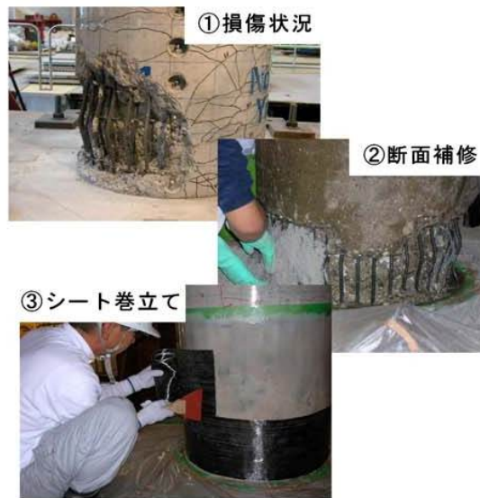
図-3 鉄筋コンクリート橋脚の迅速応急復旧
