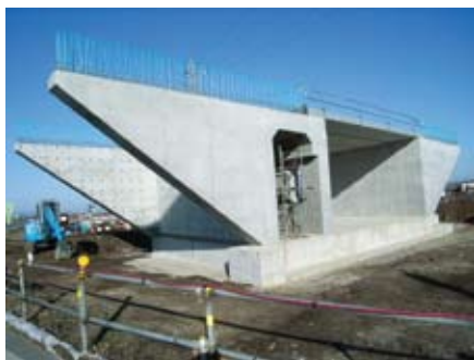
写真-1.5.29 複合構造横管渠工の施工状況
