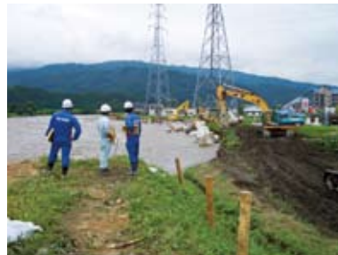
【現地調査の様子】
