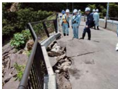
ダムの安全性確認(石淵ダム)
