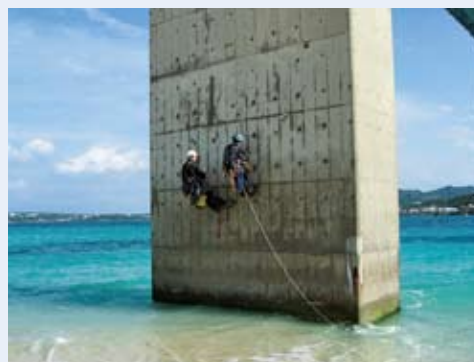
写真-2 瀬底大橋における塩害調査
