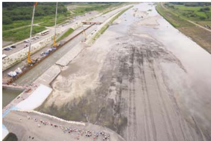
写真－1.5.24 越水破堤実験の様子
