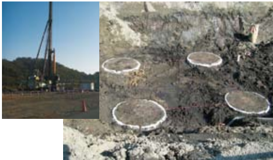
写真-1.5.28 ALiCC工法の施工状況
