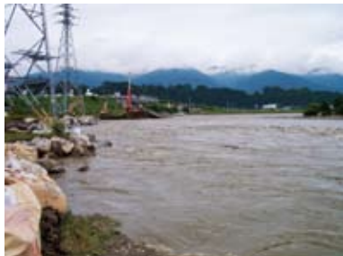
【天竜川堤防決壊状況】
