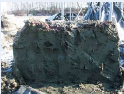
(c)凍結した大型土のう内部
