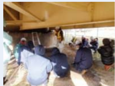
現地点検実習の状況
