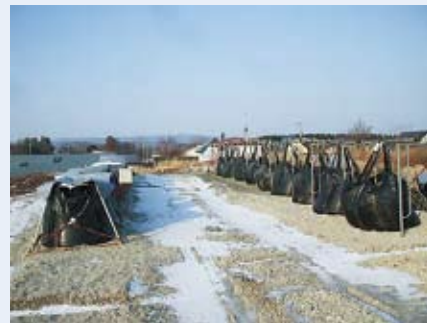
(b)冬期の土のうの状態
