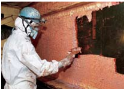
写真-1.5.27 インバイロワン工法の施工状況
