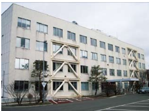
写真－7.1.1 管理棟耐震構造改修（18年度）
