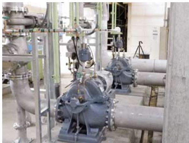
写真-7.1.5 ダム水理実験施設改修（22年度）
