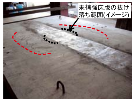
鋼板接着補強された鉄筋コンクリート床版供試体の抜け落ち範囲
