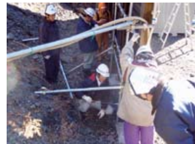
現場実証試験の実施状況
