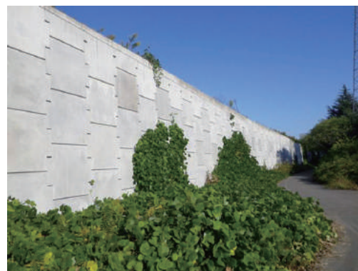
土工構造物の例：補強土壁
