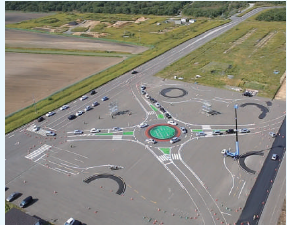
写真-1 ラウンドアバウト実験 （於：苫小牧寒地試験道路、平成 26 年 9 月）
