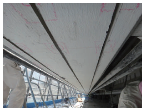
電気防食の施工
