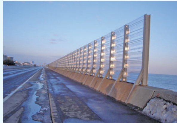
写真-2 一般国道36号白老町における設置状況
