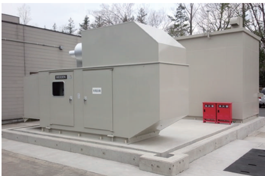
写真 -8.2.2 非常用発電設備改修
