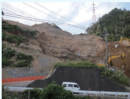
写真-1 切土工事現場（富沢IC）
