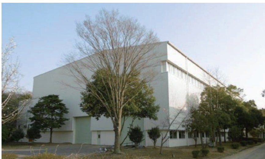
写真 -8.2.1 土木実験施設耐震改修
