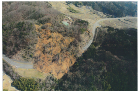
図-2.5 東北地方太平洋沖地震における県道の被災事例(管轄事務所提供)
