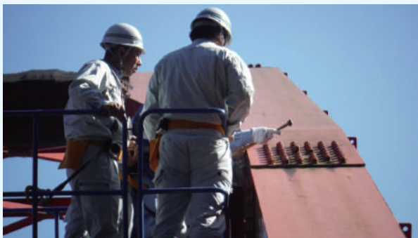
写真-1 ボルトの確認状況
