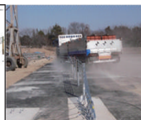
図-16.9 性能確認試験
