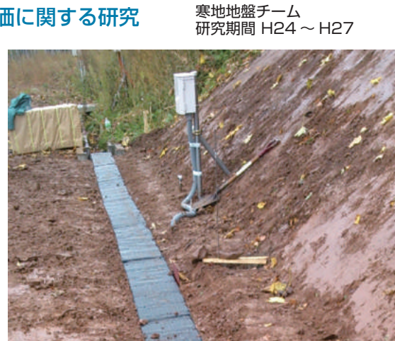
立体網状スパイラル構造を有する小段排水溝
