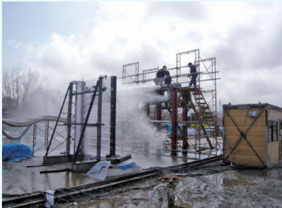
写真-1 性能確認実験、放水実験状況
