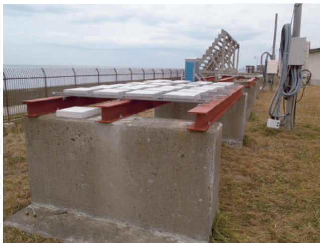
写真 -8.1.1 暴露試験の状況（留萌海岸コンクリート暴露実験場）
