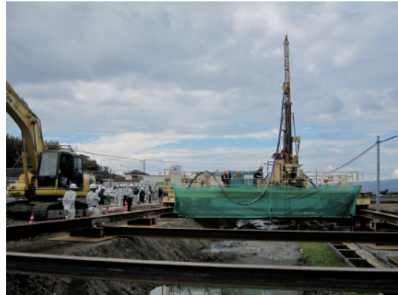
ALiCC 工法現地見学会（長崎県諫早市）
