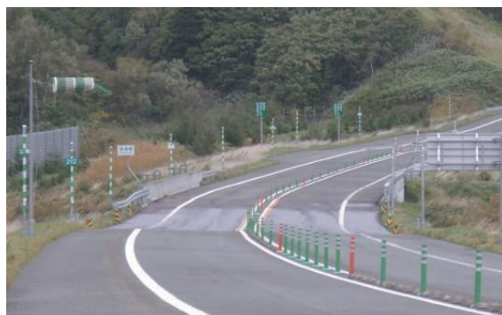
図-14.3 泥炭地盤上の道路の不同沈下
