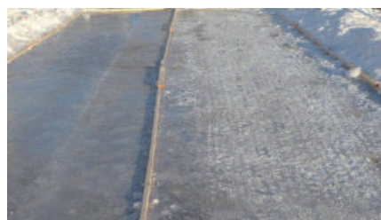
図-16.12 雪氷路面の施工前と施工後
