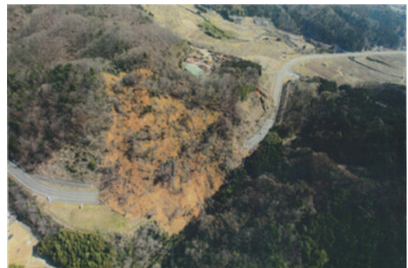
図-2.5 東北地方太平洋沖地震における県道の被災事例(管轄事務所提供)
