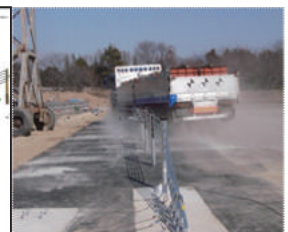
図-16.9 性能確認試験
