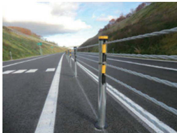
図-16.4 車線逸脱防止対策技術の導入例
