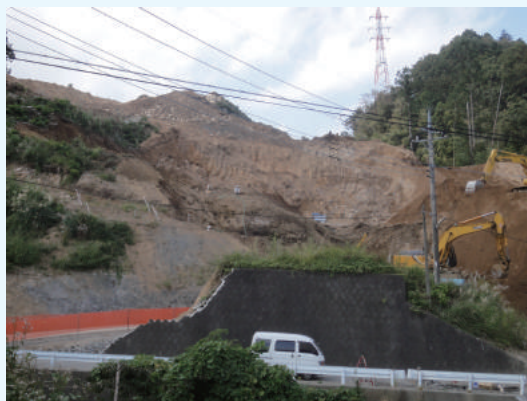
写真-1 切土工事現場（富沢IC）
