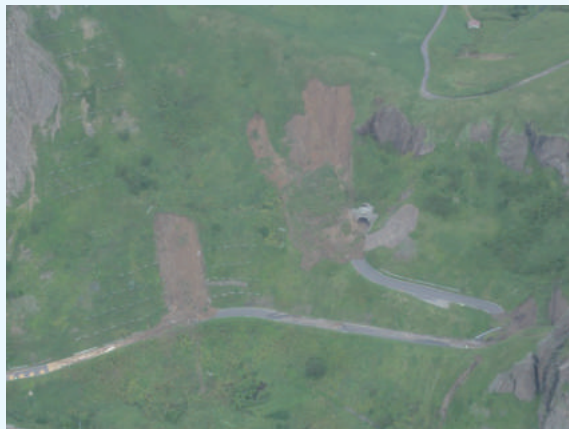
写真-1 礼文島における斜面災害
