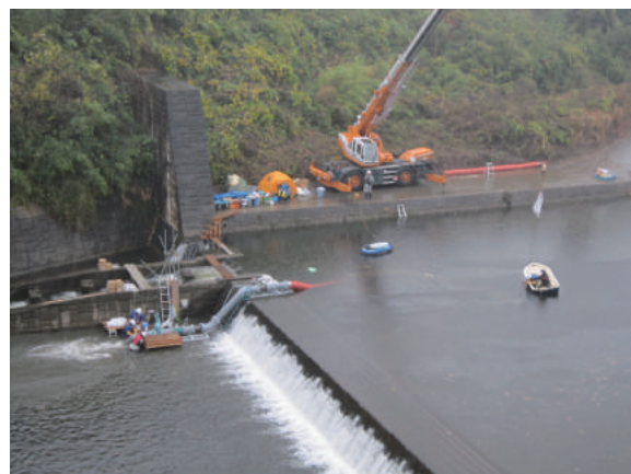
高滝ダム排砂実験見学会 実験実施状況（千葉県市原市）
