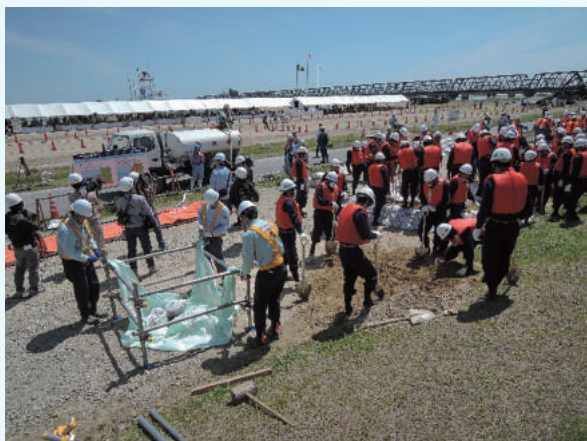
写真-1 水防演習での訓練状況 （土研式釜段）
