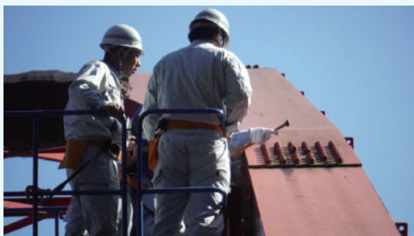
写真-1 ボルトの確認状況
