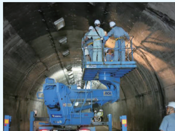
写真-2 近接目視の様子
