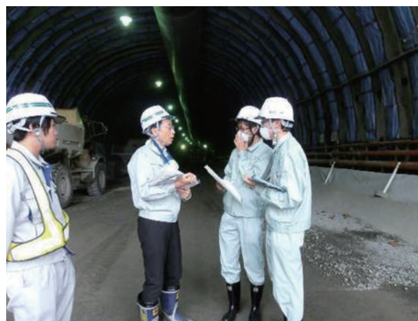
写真-1.5.3 トンネル工事現場見学
