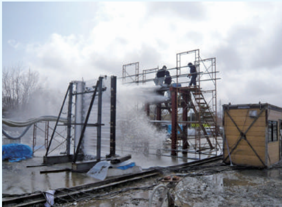
写真-1 性能確認実験、放水実験状況
