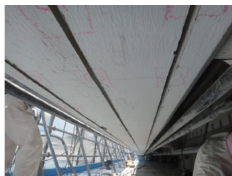
電気防食の施工
