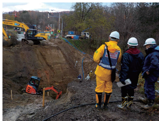
写真 - 1.2.3.6 開削による現地調査状況
