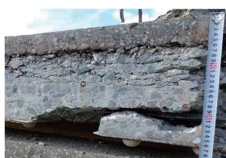
写真-1 床版の層状ひび割れ発生事例 写真-2 撤去床版の輪荷重走行試験
