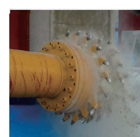
図-8 切削機械の試験施工
