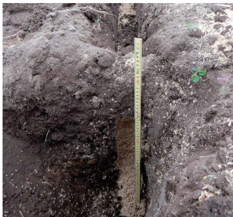
写真-2 有材心土破碎における疎水材の充填状況
