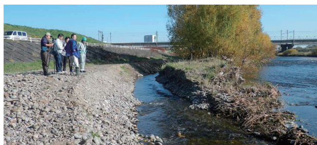
写真-1 産卵床再生試験モニタリング調査 環境改善のために掘削された alcove 上流側の掘削水路 (左) と本川 (右)
