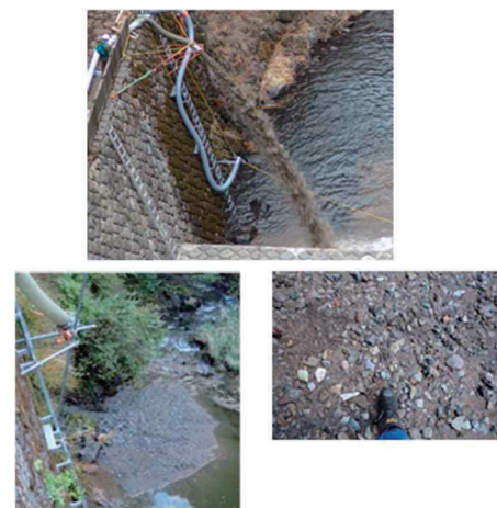
図-10 上段：ダム下流へ運搬中の土砂、下段左：ダム下流に運搬された土砂、下段右：運搬された土砂（拡大）
