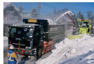
運搬排雪作業状況
