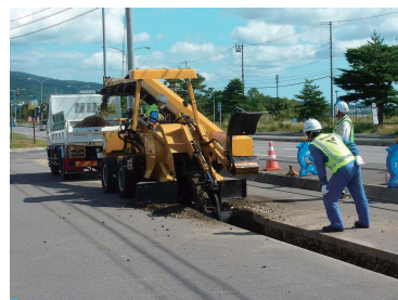
写真-2 トレンチャー掘削状況
