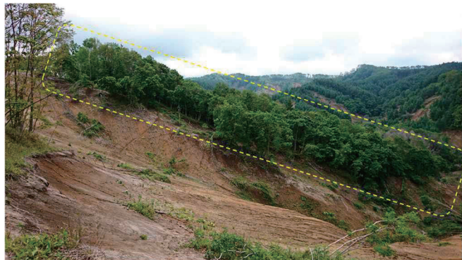
写真-1 表層崩壊（手前の裸地）と地すべり性崩壊で移動した土塊（点線枠）
