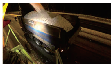
積込作業撮影状況
