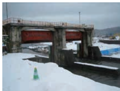
図-3 凍害と摩耗を受ける頭首工の堰柱と摩耗と腐食を受けるゲート
