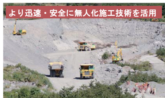
図-4 土砂災害の防止・軽減のために開発するロボット技術
