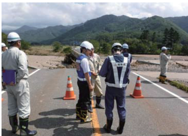
写真-1.1.5 R274 千呂露橋の現地調査状況
