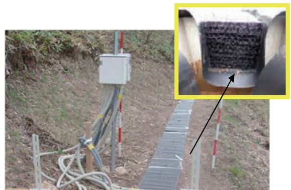
写真-4 新技術による小段排水工試験施工
