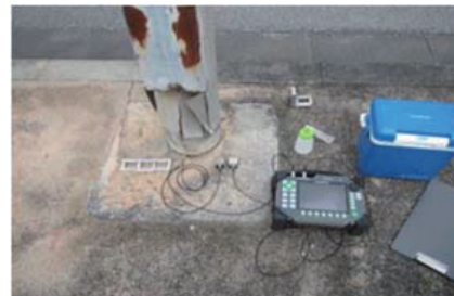
図-7 地中部腐食調査状況
