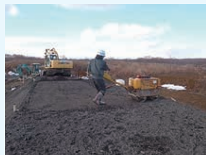
写真-2 アスファルト廃材と不良土との混合土の締固め状況
