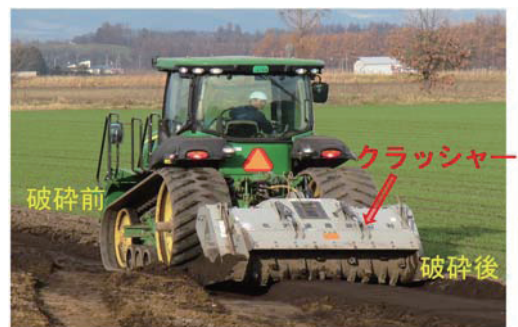
石礫破碎工法（ストーンクラッシャー）の施工状況
