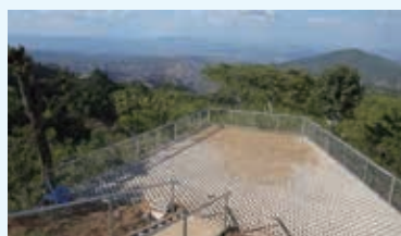
写真-4 眺望を生かした道の駅として整備中の施設（エルサルバドル）
