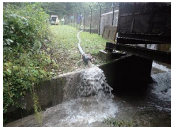
図-7 発電所沈砂池における実験の様子
