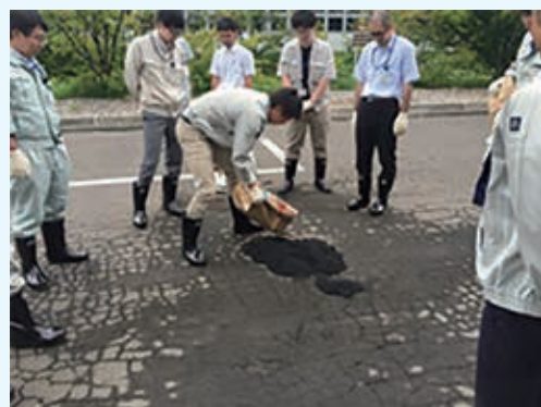
室内試験の説明状況 常温合材による補修の状況 写真-2 舗装技術を基礎から学ぶ勉強会（北海道開発局） 実習の状況
