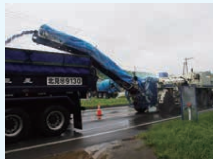
写真-1 舗装切削工事
