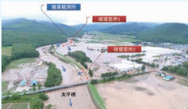
写真-1 空知川の被災状況
