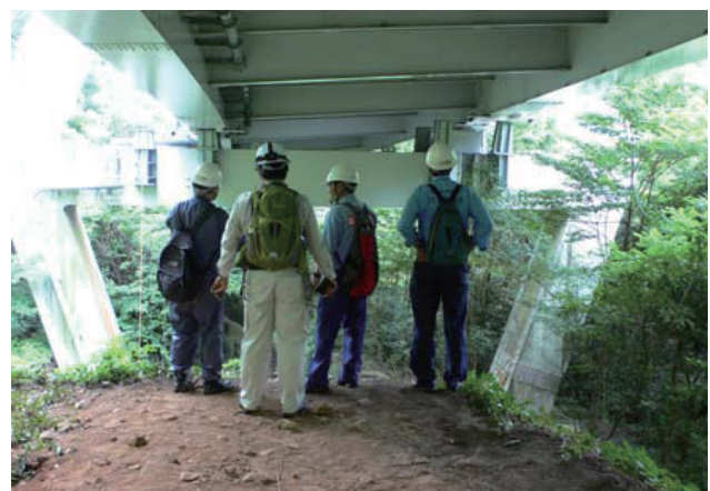
写真-1.1.2 被災橋梁の損傷状況調査
