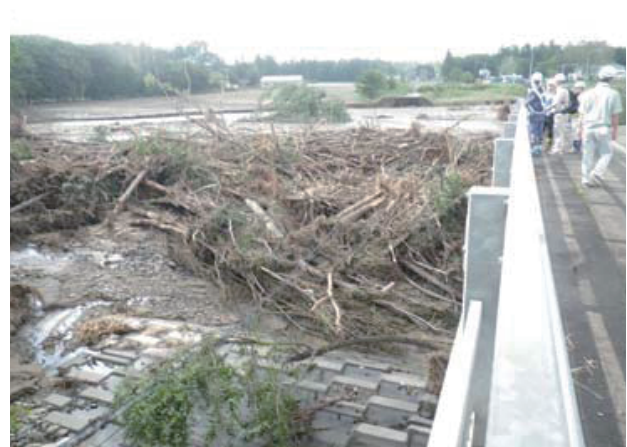
写真-1.1.6 R38 小林橋の現地調査状況
