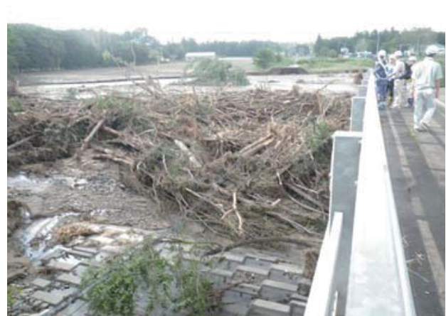
写真-1.1.6 R38 小林橋の現地調査状況
