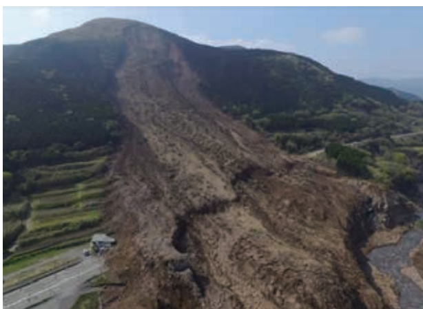
写真-1.1.1 斜面崩壊の状況
