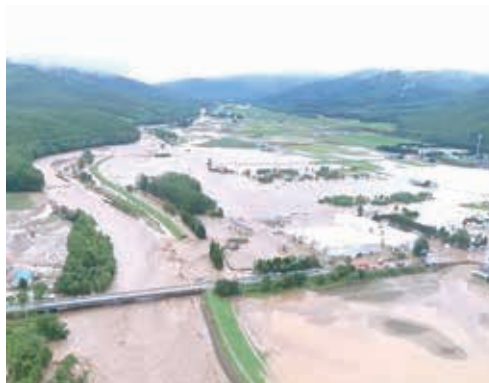
図-1 石狩川水系空知川の破堤状況 (平成28年8月)
