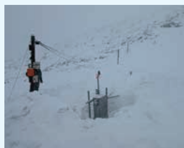
写真-3 十勝岳避難小屋周辺の機器設置状況
