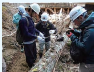
写真-2 地質調査の様子
