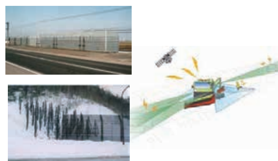
図-5 防雪柵の端部対策 図-6 除雪車運行支援（イメージ）
