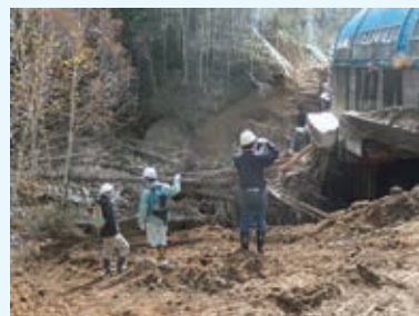
写真-1 室蘭工業大学との共同現地調査の様子
