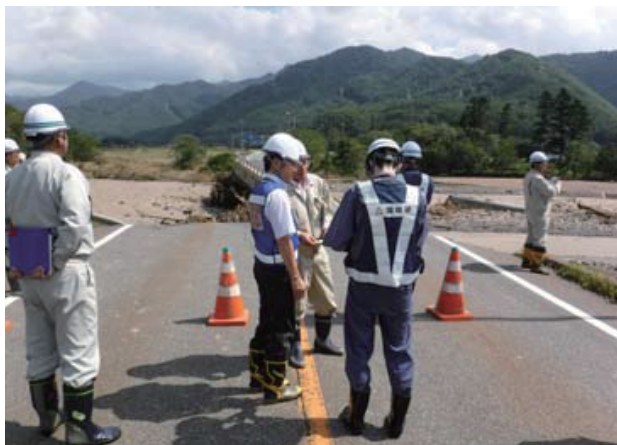
写真-1.1.5 R274 千呂露橋の現地調査状況
