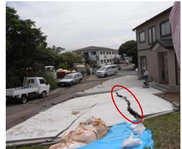
堤内地の状況(地点A)
