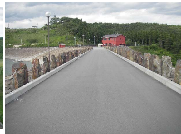
堤体天端舗装面に 変状見られない
