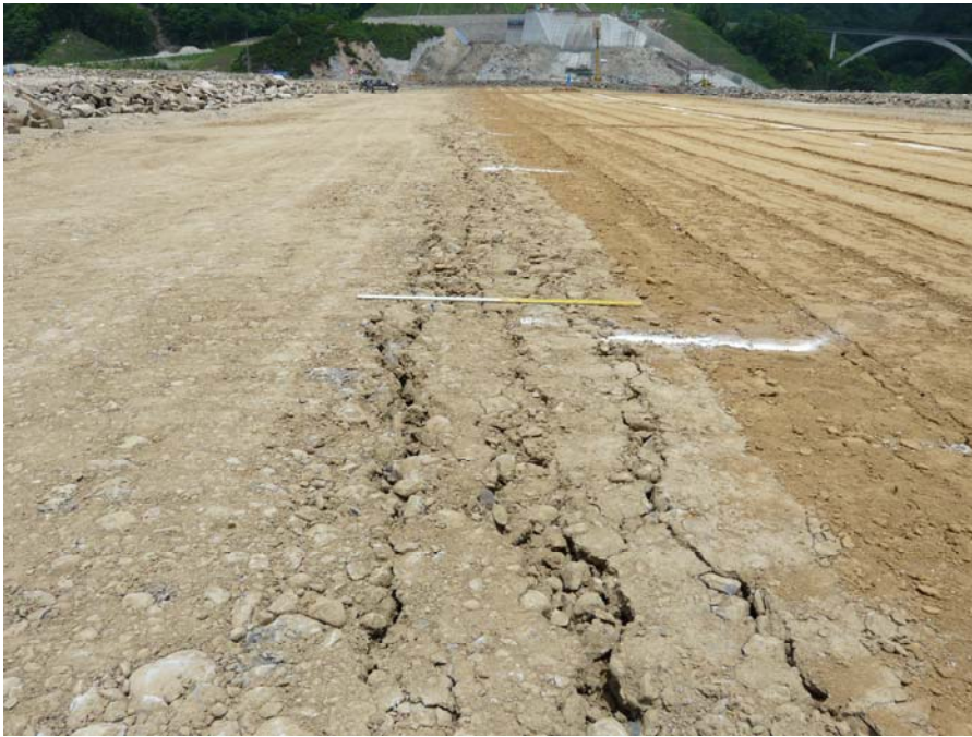
堤体盛立面に生じた亀裂
