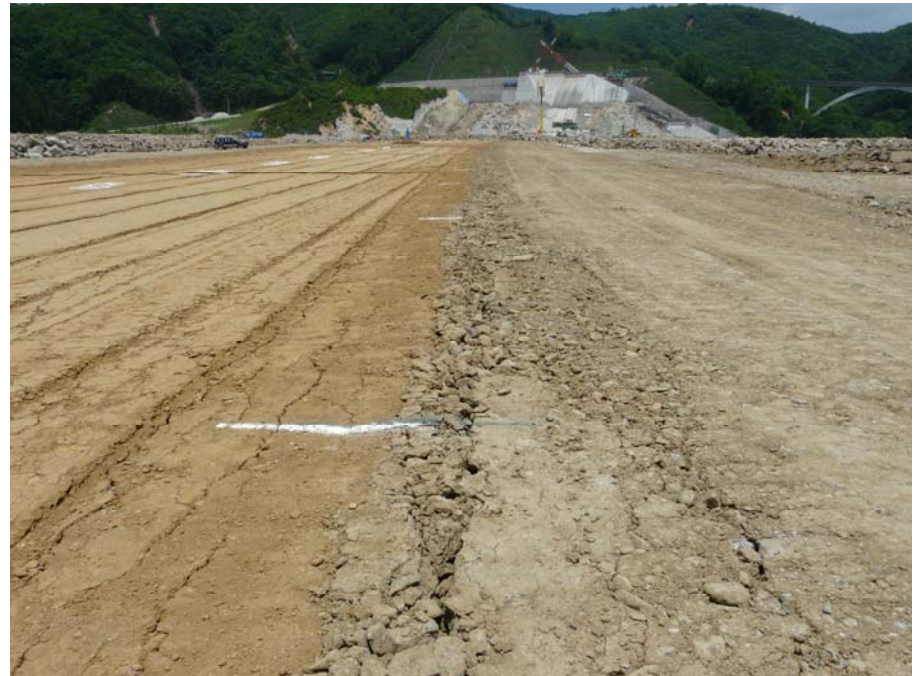
堤体盛立面に生じた亀裂
