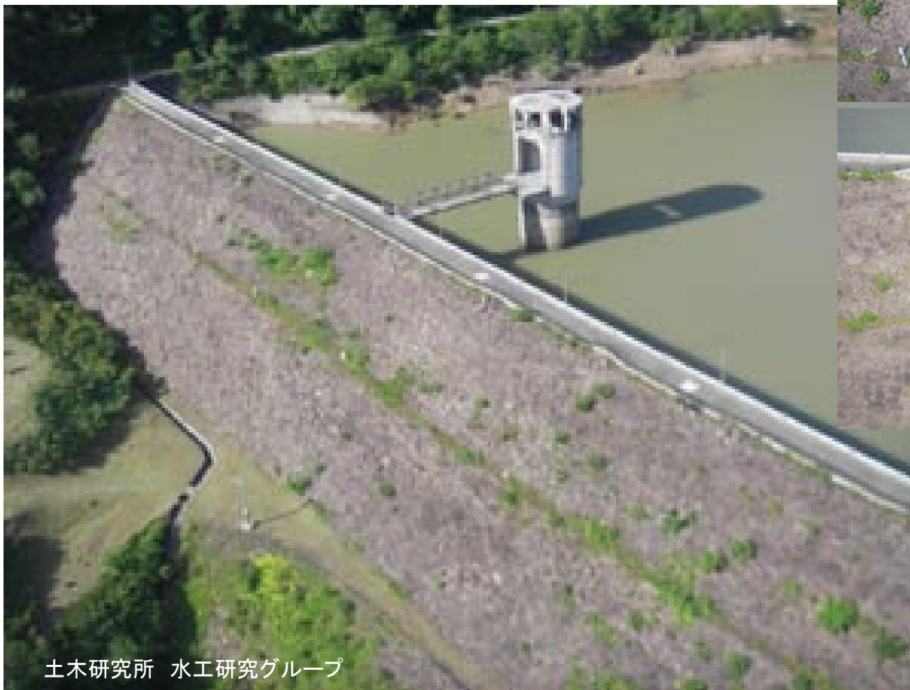
天端舗装の波打ちと下流法肩部における突出部の状況（2008年6月15日撮影）
