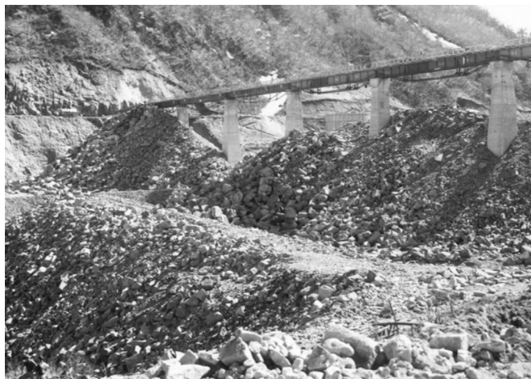
建設時の状況
