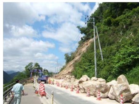
山側切土のり面(のり枠+ロックボルト工)の上方自然斜面で岩盤崩壊が発生
