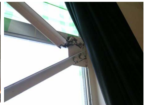
鉄骨ブレース座屈+破断 (全数)
