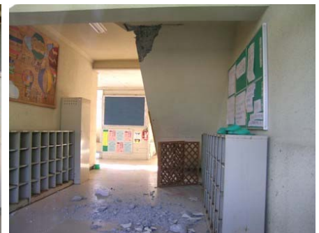
階段部損傷
