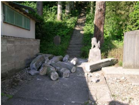
鳥居倒壊(除去済み)(大崎市上野目)
