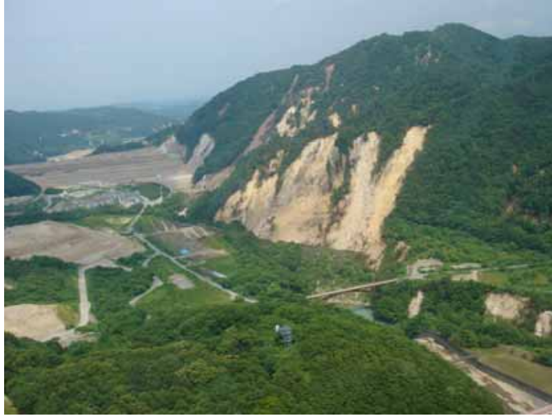
地震による表層崩壊(と岩盤崩壊) (2008 岩手宮城内陸地震)
