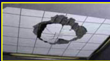
普通吹付けモルタル + AFRP メッシュ
