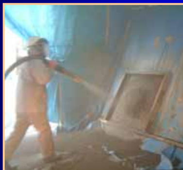
斜め下向き吹付け (圧送・吐出性状の確認)
