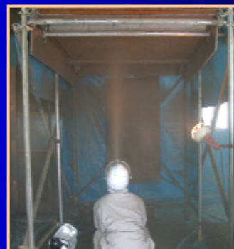
上向き吹付け (付着性状の確認)
