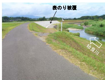
質的整備後の状況(天端道路から撮影)
