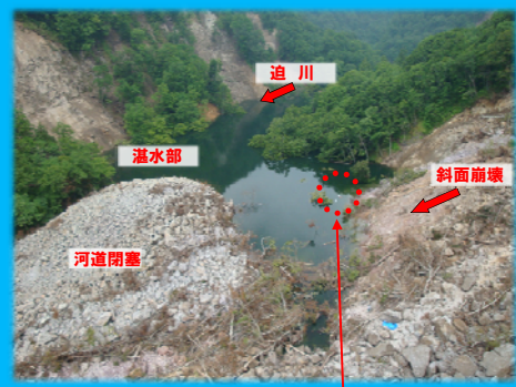
投下型水位観測パイの設置位置
