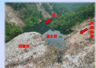
湯浜地区天然ダム状況
