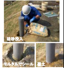
保孔管周辺の 埋め戻し例
