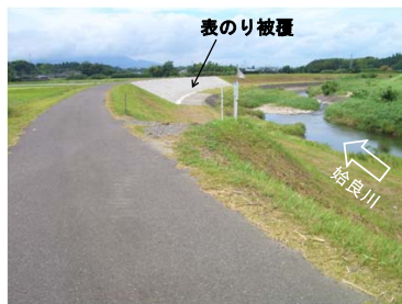
質的整備後の状況(天端道路から撮影)
