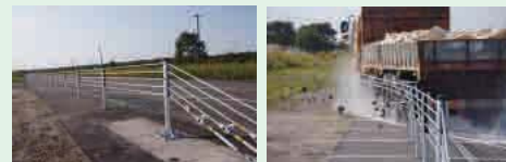
ワイヤーロープ式防護柵と衝突実験（大型貨物車）の様子
