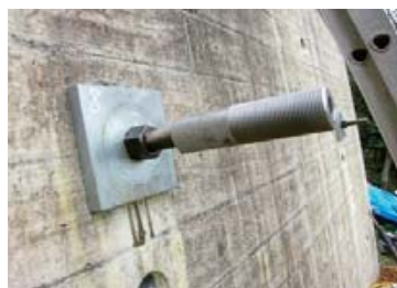
● アンカー余長部にアタッチメントを取付け
