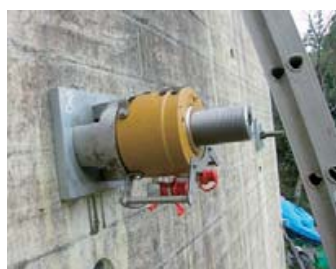
● SAAMジャッキを取付け
