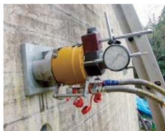
● 止めナット・高圧ホース・変位計を取付け設置完了
