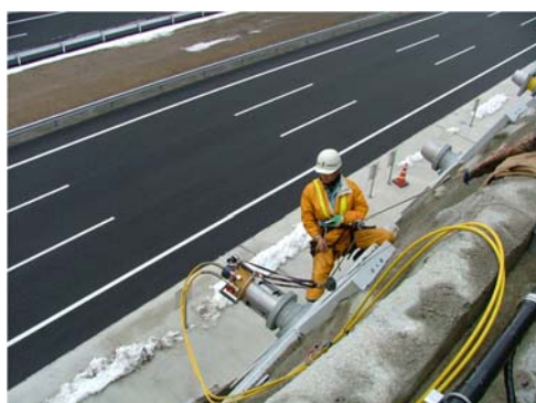
高所での調査
