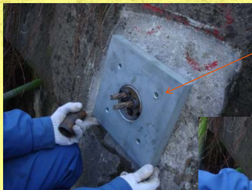
アンカーヘッド一体型支圧板
