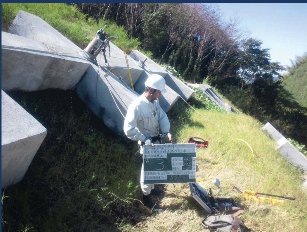
SAAMジャッキを用いたリフトオフ試験及び緊張力の調整
