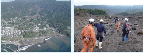
東京都大島町豪雨災害(2013年10月)
