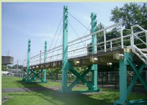
FRPの歩道橋構造材への適用と耐久性検討 (主部材: 構造用GFRP、斜材: CFRPケーブル)
