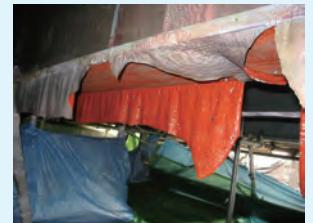
塗膜の除去状況
