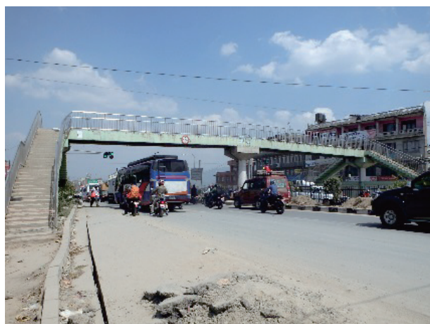
写真-4 アルニコハイウェイの横断歩道橋の基礎の変位による橋桁部でのずれ
