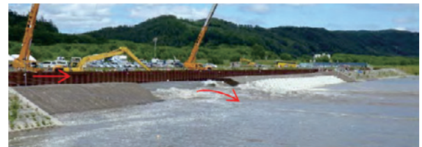
図-20 根固めブロックに破堤が到達
