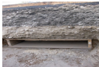
写真-4 模擬空洞敷設状況 (空洞 A)
