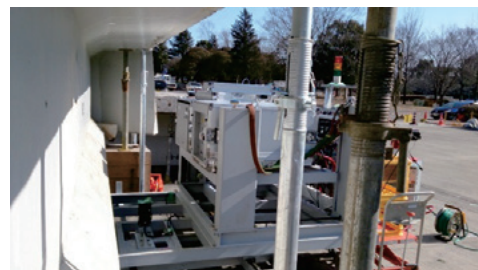
図-4 撤去桁の撮影
