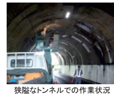
狭隘なトンネルでの作業状況
