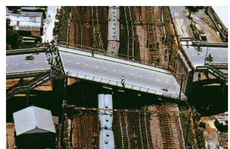
写真－2 液状化による下部構造の傾斜・沈下による橋の被害
