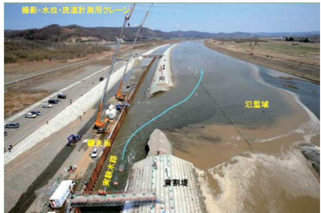
図-2 千代田実験水路の全体風景
