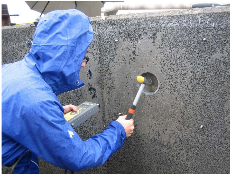
観測孔による既設水路の観察状況
