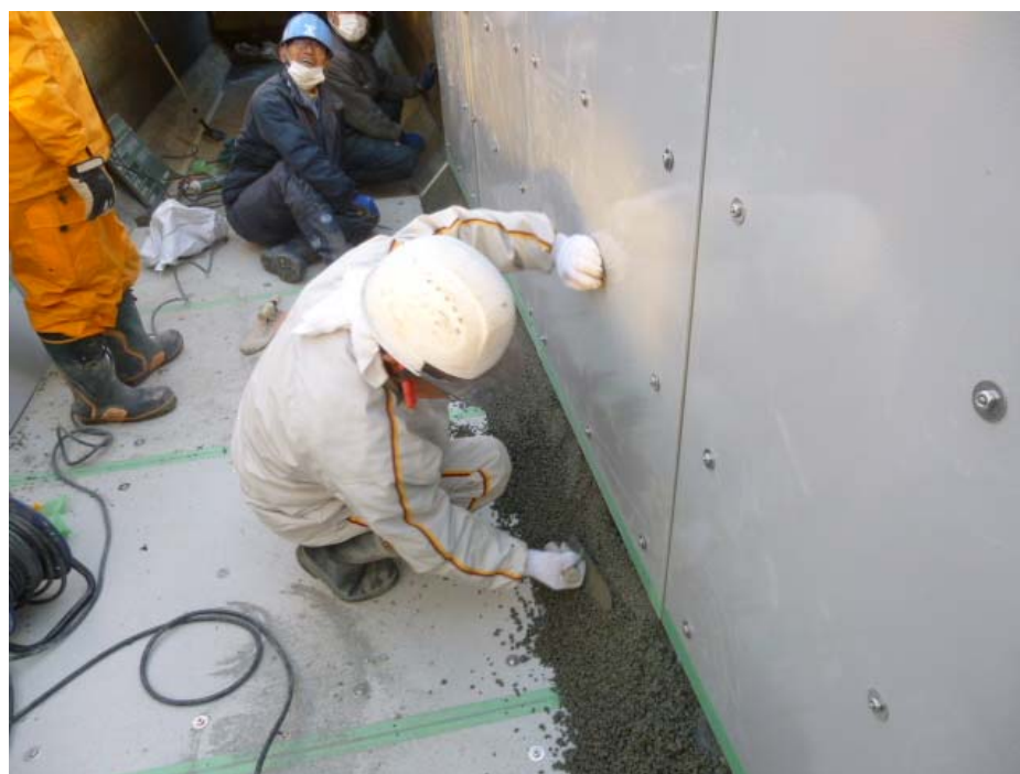
④FRPM板の側壁設置
