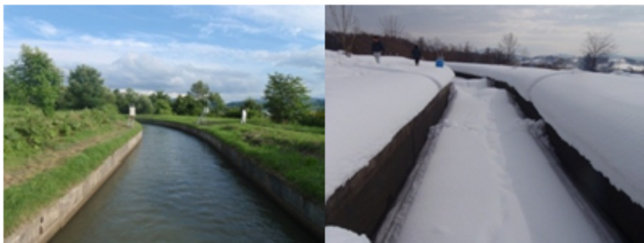
開水路の供用環境（左：灌漑期、右：冬期）
