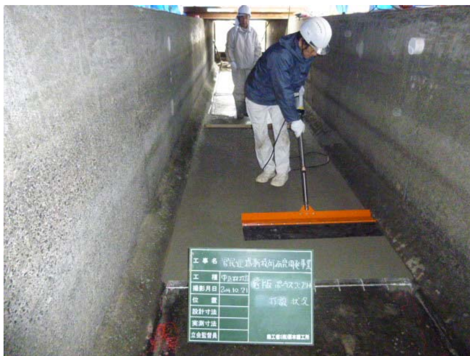
②ポーラスコンクリートの底版打設
