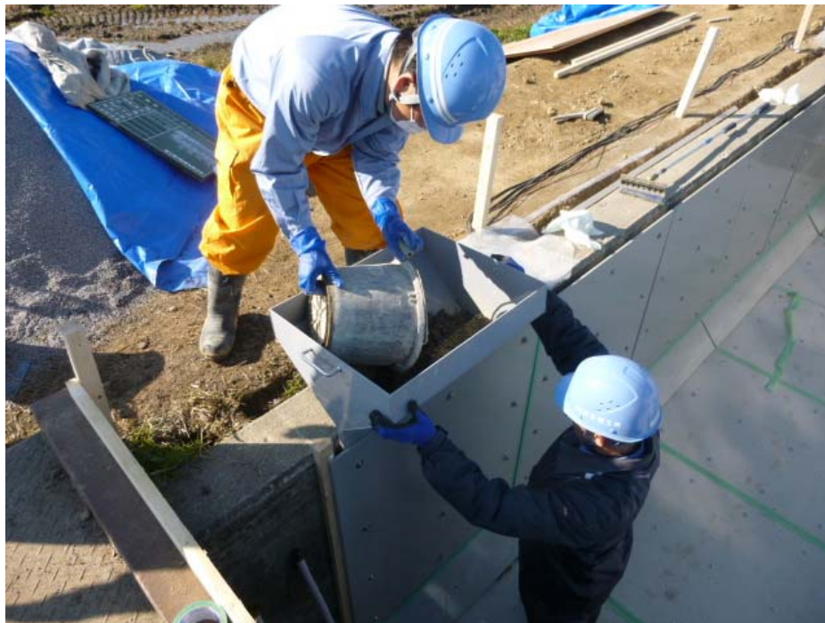
⑤ポーラスコンクリートの側壁打設
