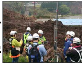
緊急消防援助隊との打合せ状況
