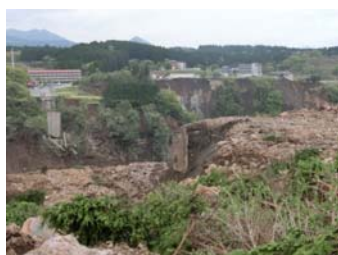
阿蘇大橋の被災状況
