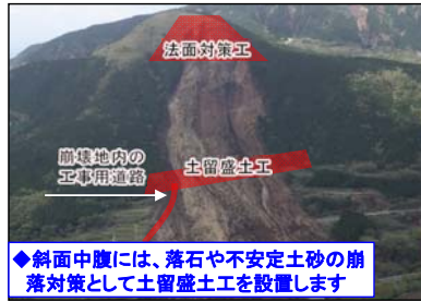
◆斜面上部の不安定土砂を取り除き法面对策工を実施します
