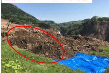
崩壊により黒ボク土が斜面下部に堆積
