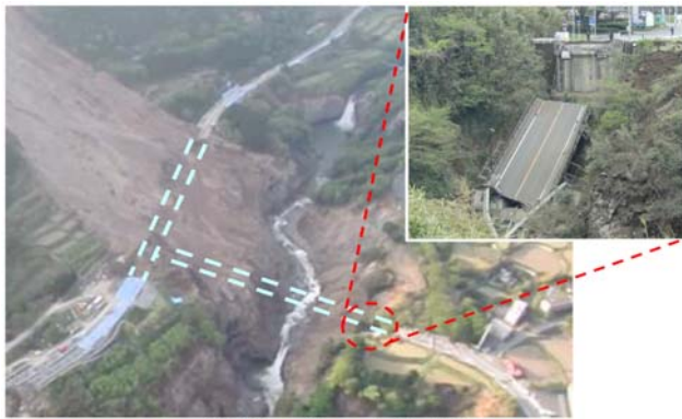
地盤変状による落橋
