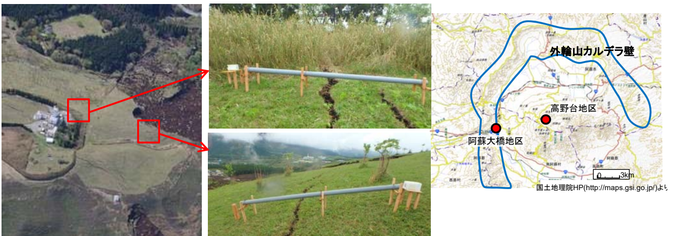
熊本県南阿蘇村高野台地区の亀裂（亀裂の幅を計測する伸縮計を設置）
