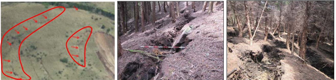
阿蘇大橋地区西側斜面の崩壊箇所 上部亀裂状況
