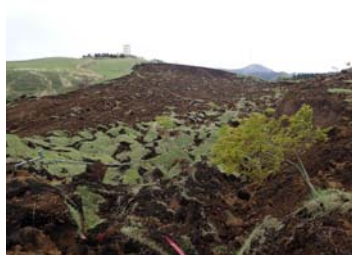
南阿蘇村高野台地区の斜面崩落
