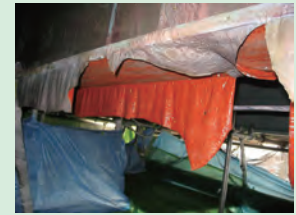
塗膜の除去状況
