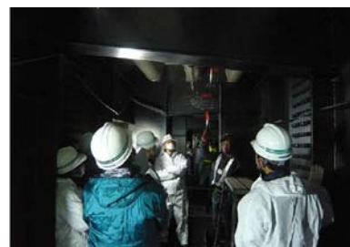
～橋梁補修に関する視察～ 鋼床版の亀裂補修
