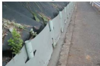
防草シート等を設置し通行環境確保
