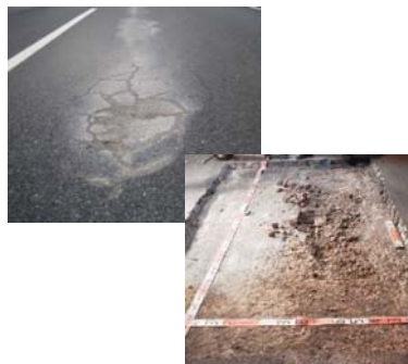
床版のひびわれ、漏水、遊離石灰
