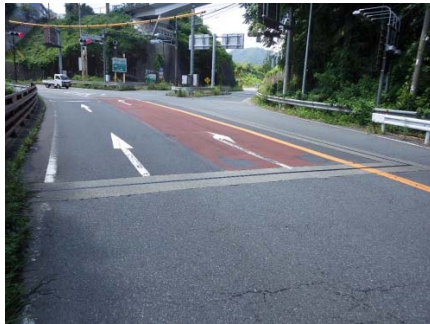
伸縮装置の取り換え (漏水対策)
