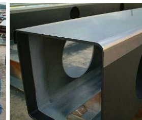
チタン箔シート貼付後状況
