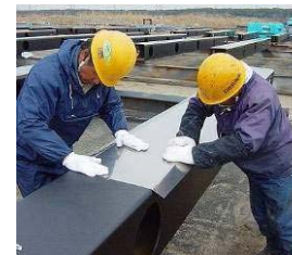
チタン箔シート貼付作業状況
