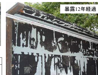
チタン箔シート除去後の状況
