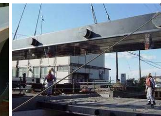
橋梁架設状況
