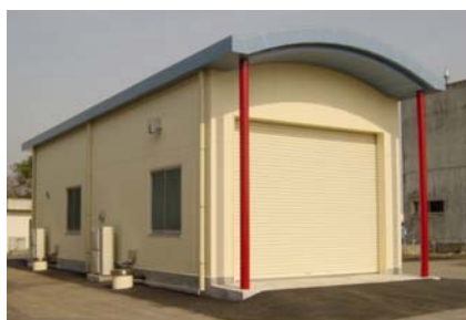
FWD検定施設の外観
