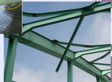
ガセットの破断
