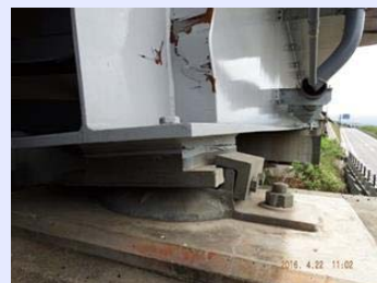
ガセットの破断
