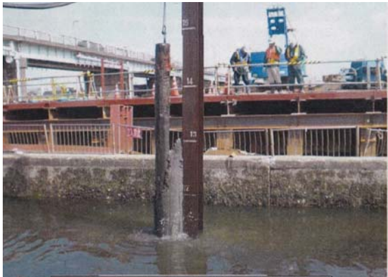
軟弱地盤に立地する堰の改修工事で，擁壁周辺及び前面に打設されていた松杭を引き抜いたところ，擁壁が川側へ変位。
