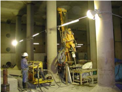
低空頭な空間での基礎補強工事
