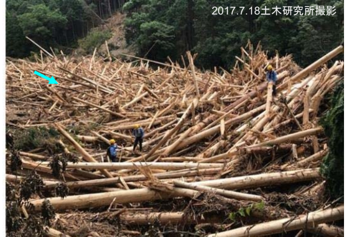
須川第一砂防堰堤における流木の捕捉 状況(妙見川)
