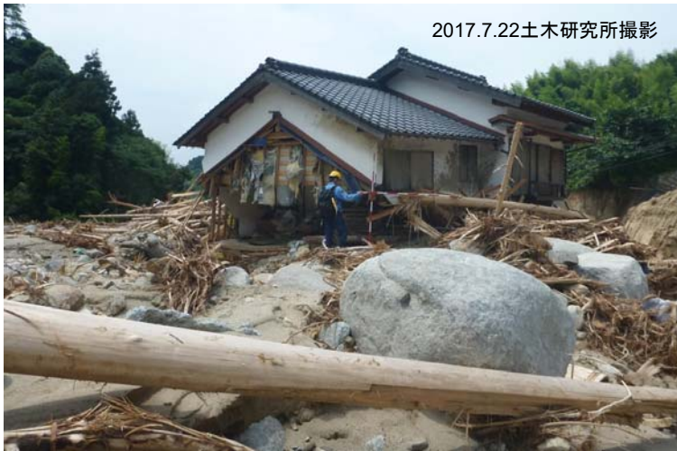
北川の土砂・流木による家屋被災例
