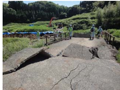
平井川に架かる橋の損傷 (2017年6月5日撮影)
